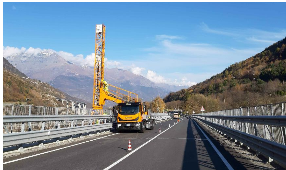
SS24 'del Monginevro', Piemonte - ispezioni con by bridge sui viadotti
