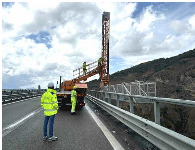
**Oltre alle ispezioni visive di tipo "strutturale/fondazionale e sismico", estese a tutte le opere gestite in termini di almeno una ispezione ordinaria nell'anno, vengono svolte ulteriori ispezioni visive per valutare il "rischio frana" e il "rischio idraulico".**
