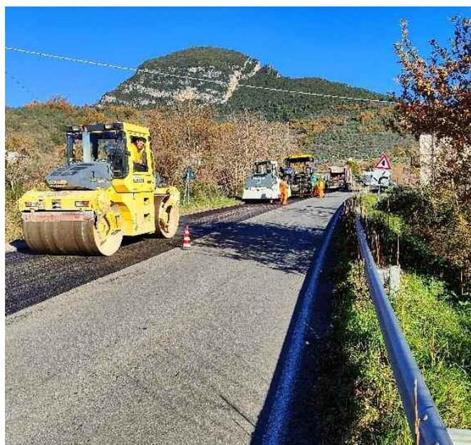
Proprio con queste finalità **è in corso una sperimentazione** presso il Centro di Ricerca e Sperimentazione Stradale di Cesano che prevede l'utilizzo di additivi con la funzione di riattivare, attraverso rigeneranti, il bitume ossidato del fresato e di abbassare la viscosità stessa del bitume consentendo di diminuire le temperature di confezionamento e stesa del conglomerato bituminoso, mantenendo alta l'adesione bitume-inerte (attivanti di adesione).
