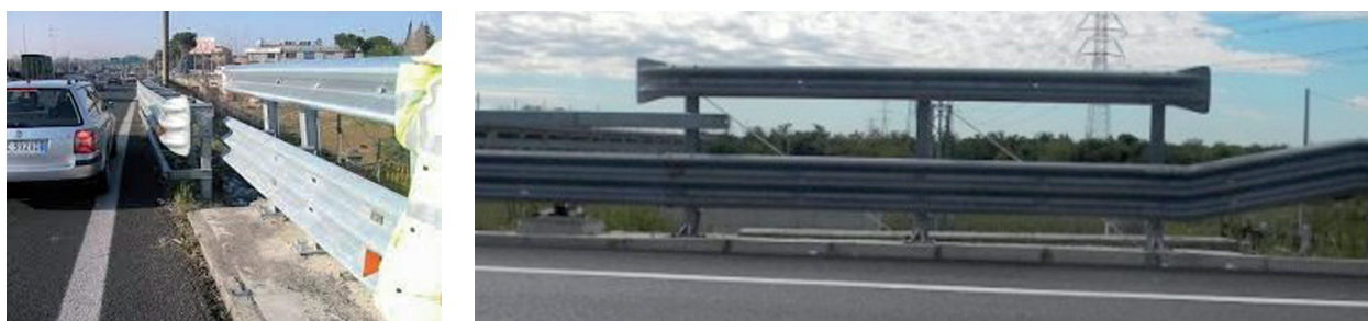
Figura 8-16: modalità non corrette di transizioni tra barriere differenti
