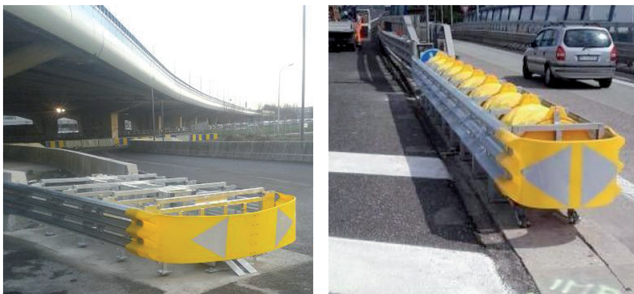
Figura 8-11: Attenuatore d'urto di tipo largo (sinistra) e stretto (destra)
