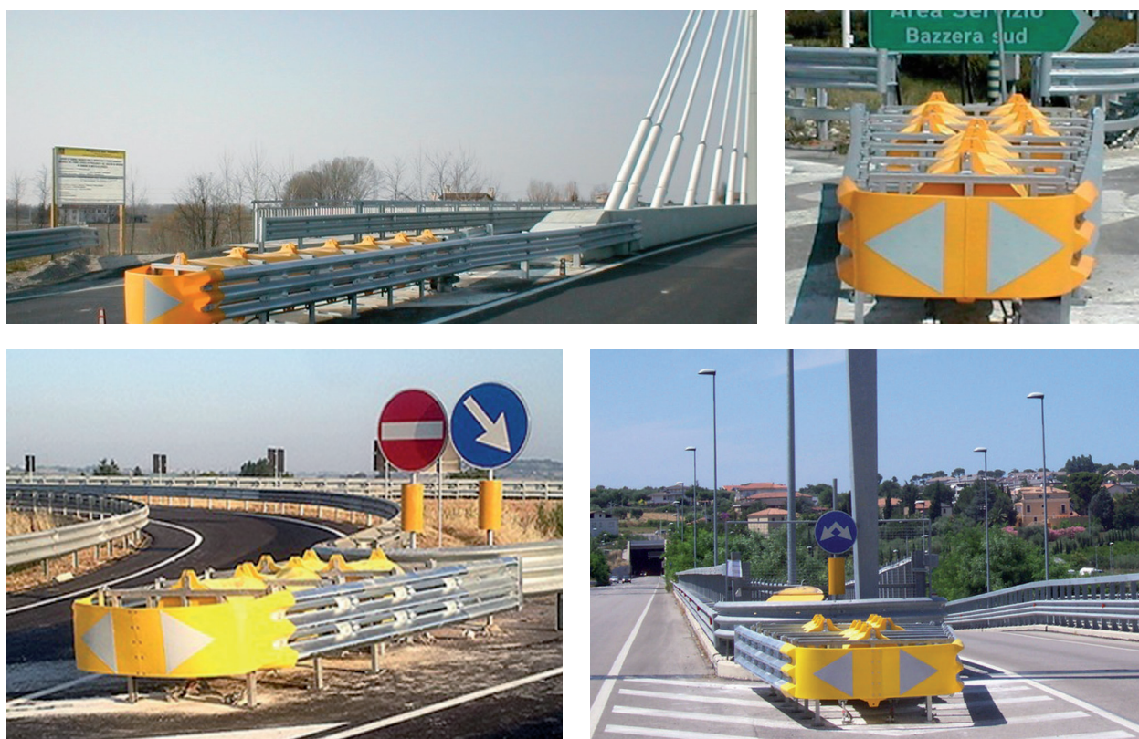
Figura 8-8: Esempi di installazioni di attenuatori d'urto
