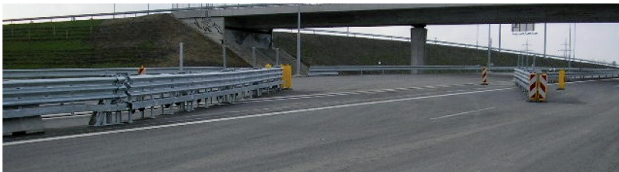
Figura 8-20: Chiusura varco in condizioni di apertura
