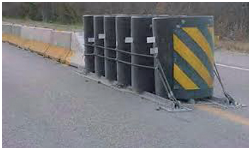
Figura 8-10: Attenuatore d'urto di tipo inerziale
