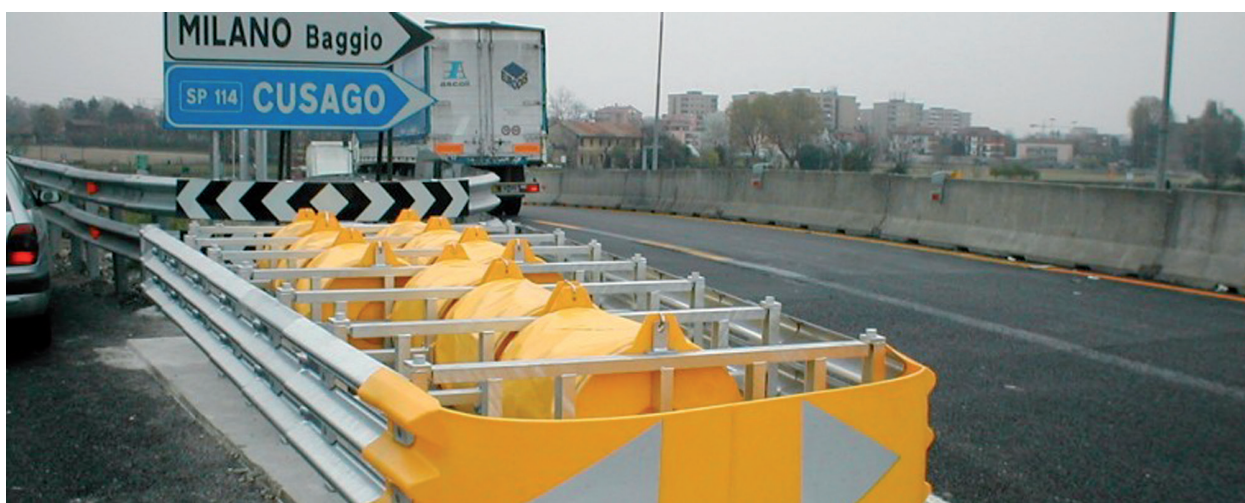
Figura 8-9: Attenuatore d'urto di tipo cinetico
