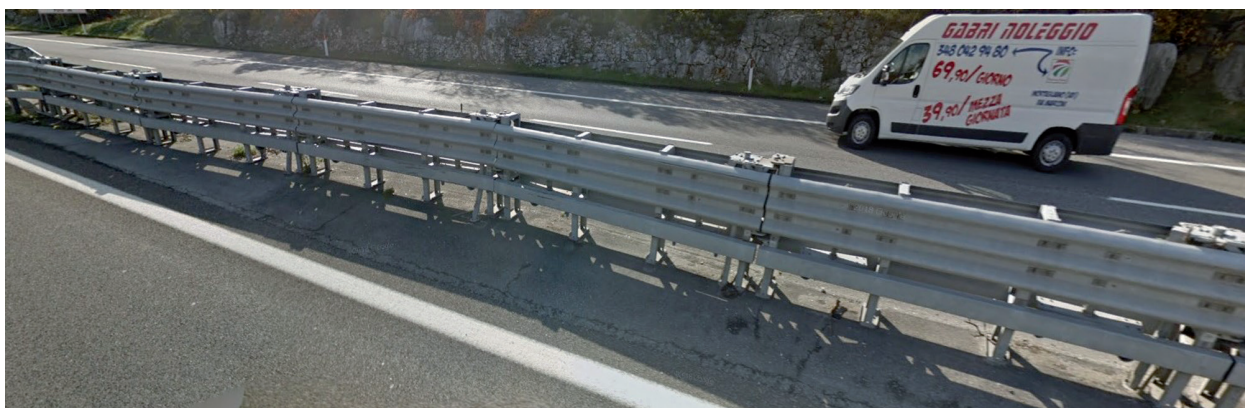
Figura 8-21: Chiusura varco in condizioni di chiusura
