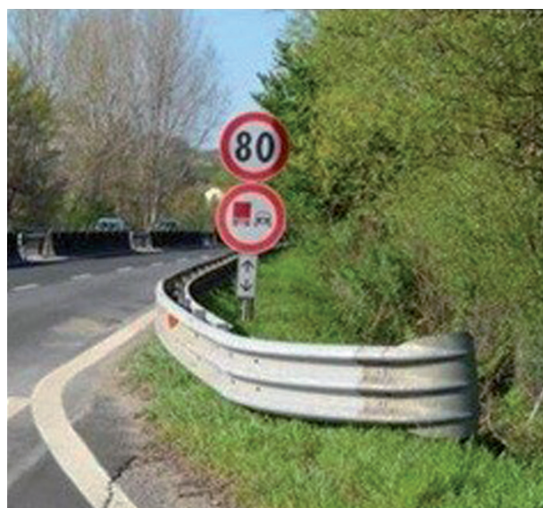
Figura 8-3: Terminale semplice ben installato
