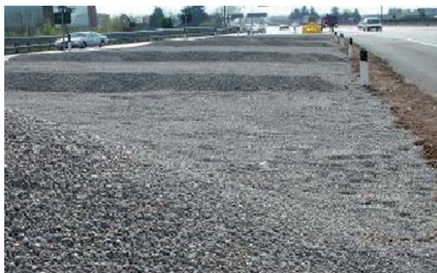
Figura 8-13: Particolari del letto di arresto
