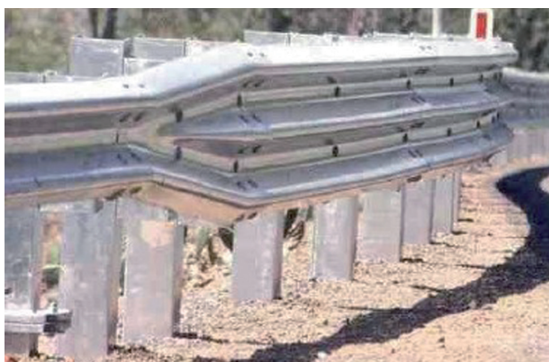
Figura 8-15: transizione tra barriere dello stesso materiale e in materiali differenti
