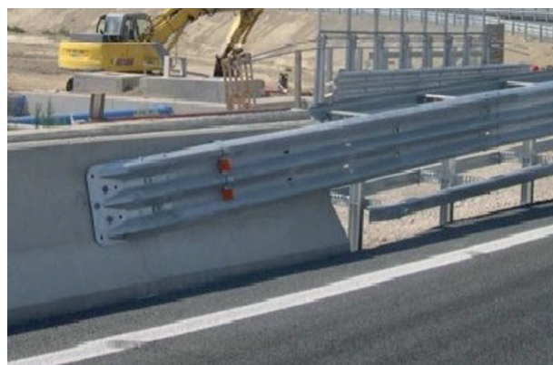
Figura 8-15: transizione tra barriere dello stesso materiale e in materiali differenti
