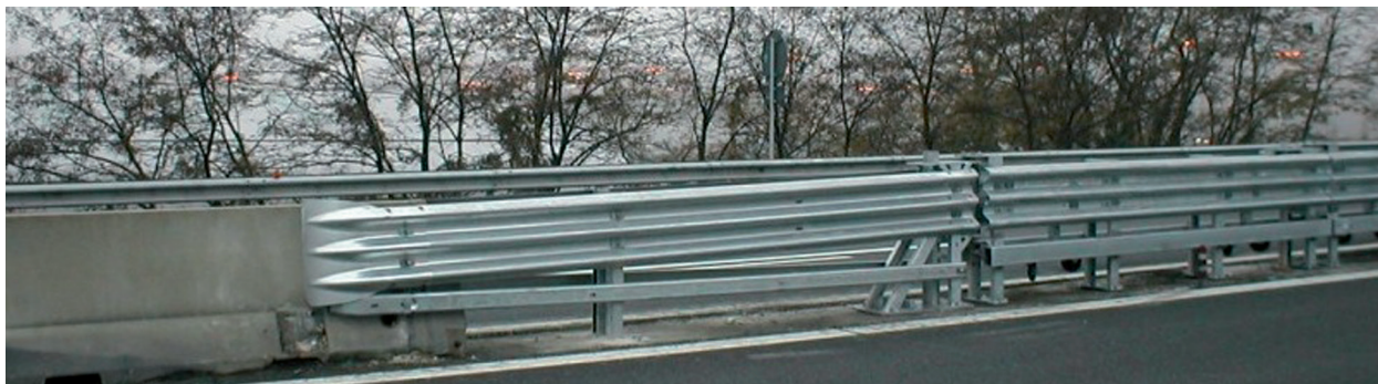
Figura 8-23: Transizione in chiusura varchi
