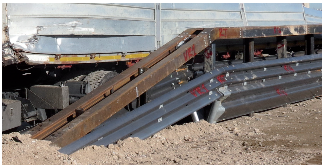
Figura 8-5: Terminale immerso su scarpata
