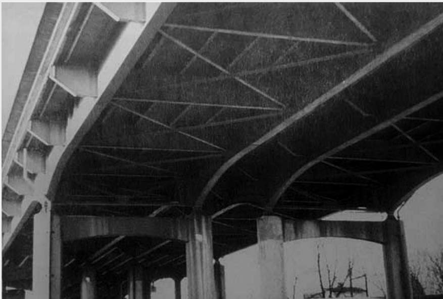
Figura 11. Esempio di impalcato in buone condizioni [2].
