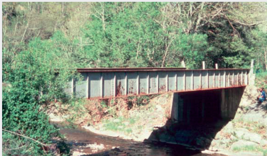
Figura 27. Esempio di danneggiamento per corrosione [3].
