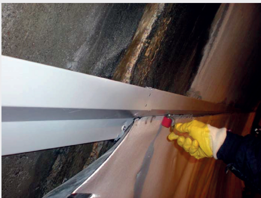
Fig. 13 Accoppiamento con il telo in TPO.
