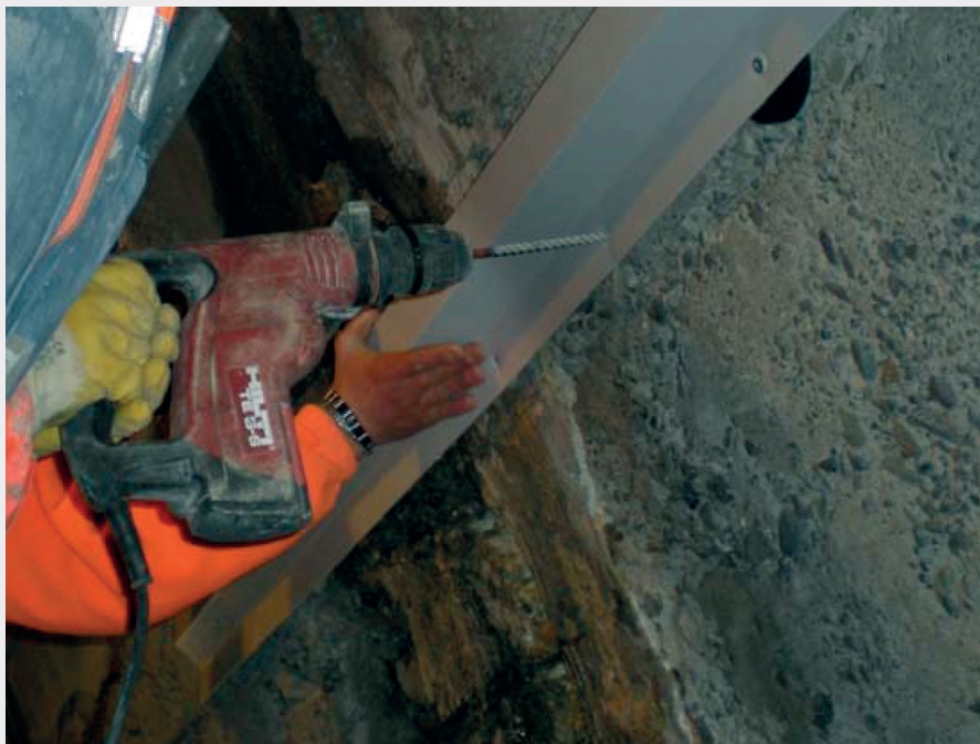
Fig. 12 Fissaggio della scossalina superiore.
