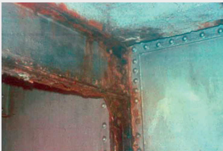
Figura 22. Degrado zona di estremità di un trasverso [3].
