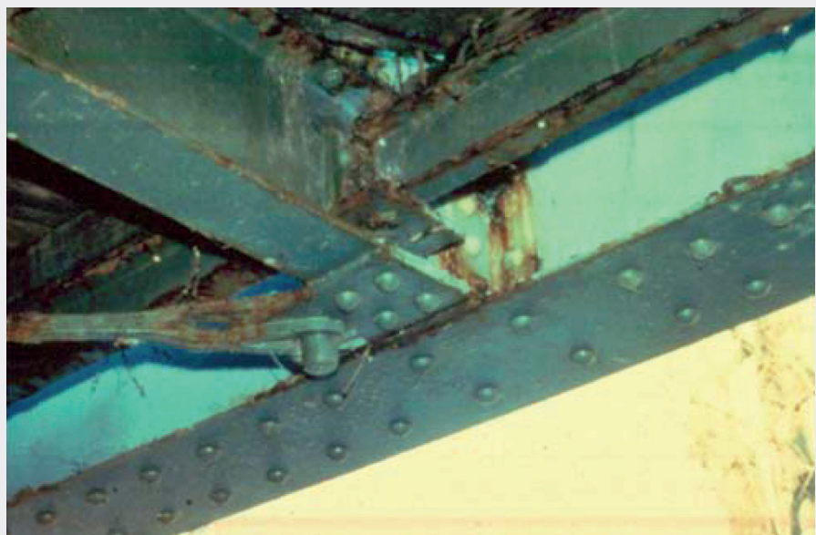
Figura 10. Esempio di danneggiamento per corrosione delle travi principali e trasversali.
