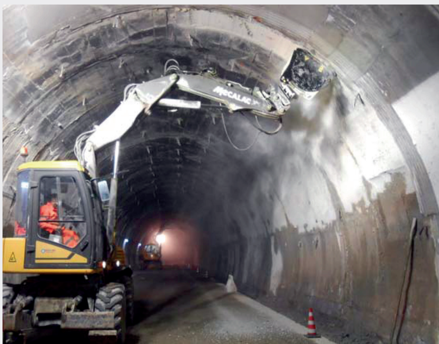
Fig. 11 Preparazione del supporto: idrodemolizione.
