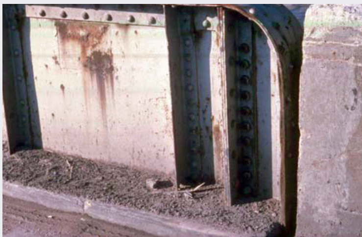
Figura 23. Degrado per corrosione dell'anima della trave di un impalcato a travi estradossate [3].
