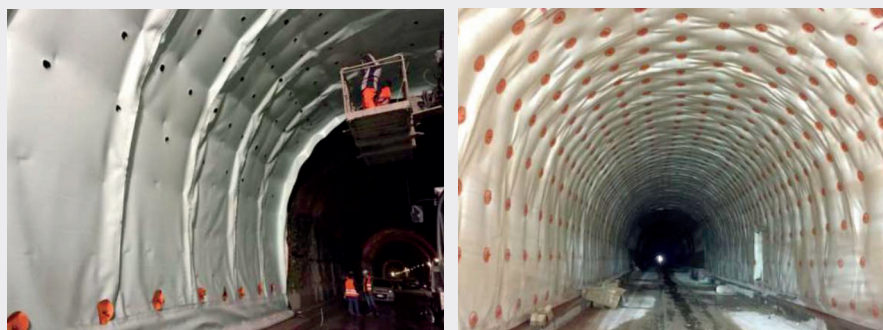
Fig. 7. Installazione dei punti di ancoraggio.
