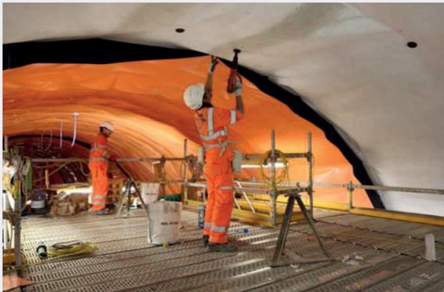
Fig. 4. Installazione dei dischi di fissaggio.
