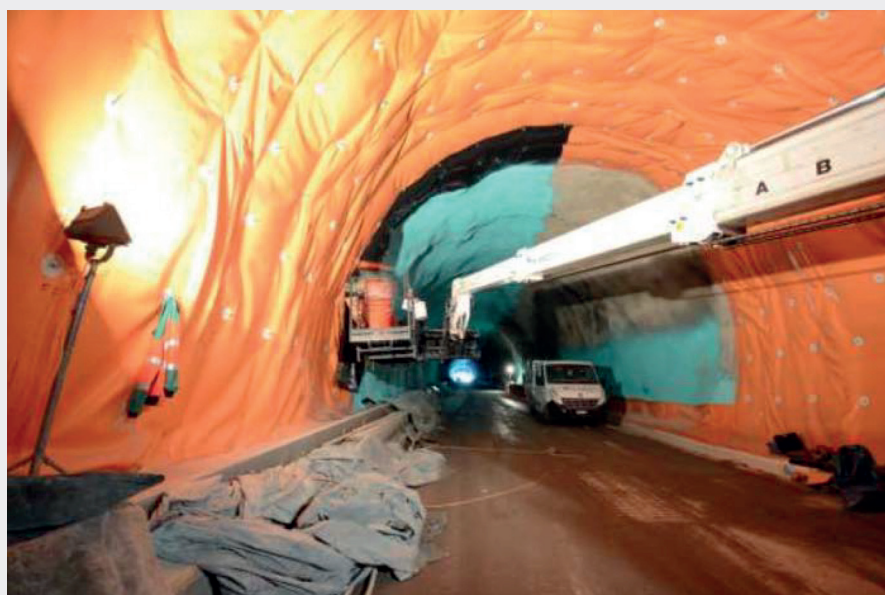
Fig. 23. Sistema misto accoppiato membrana preformata in PVC - membrana a spruzzo.
