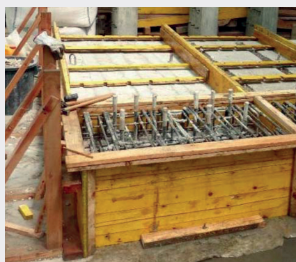
Figura 36. a) Cassaforma per getto cordolo; b) Elemento completo.
