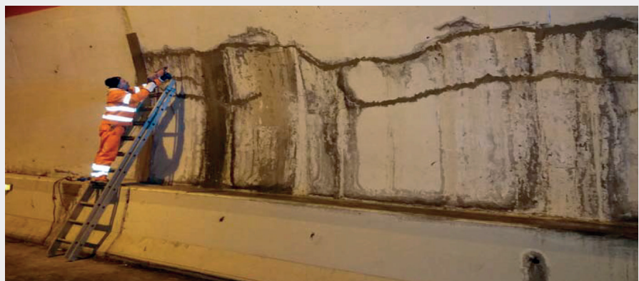
Fig. 9. Iniezione della fessura
