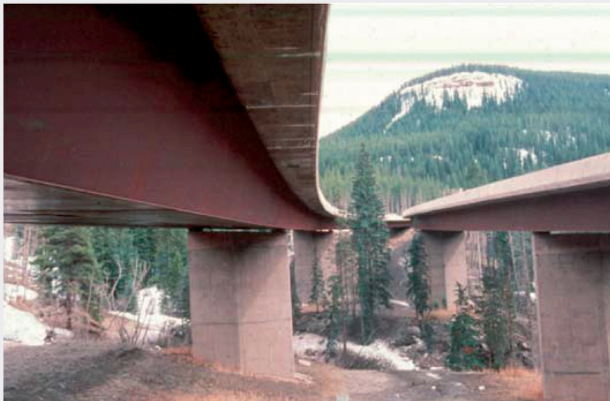
Figura 4. Esempio di impalcato misto acciaio-calcestruzzo con schema a cassone [3].
