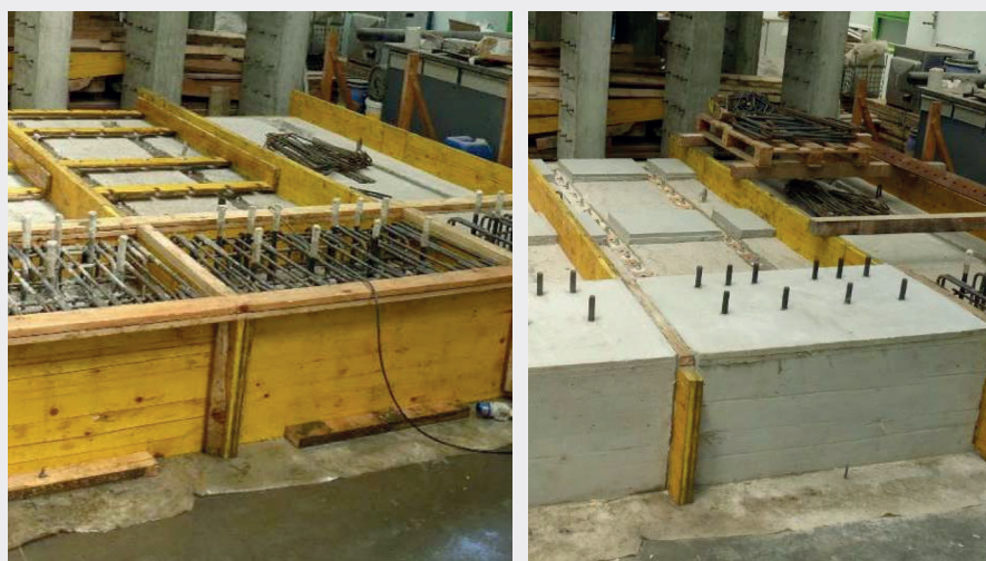
Figura 44. a) Cassaforma per getto cordolo; b) Elemento completo.
