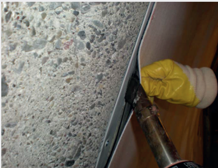
Fig. 14 Saldatura del telo al profilo laterale.
