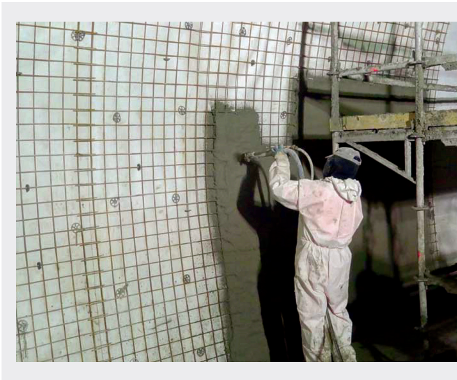
Fig. 16 Applicazione dello strato di malta cementizia di classe R4 di finitura.
