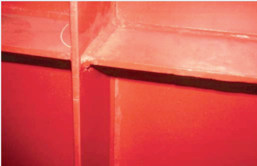
Figura 28. Dettaglio verniciatura elemento metallico [3].
