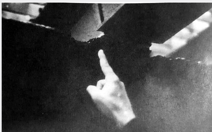
Figura 13. Esempio di danneggiamento per presenza di ruggine [2].
