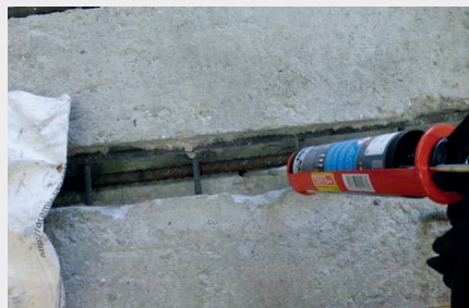
Figura 34. Dettagli posizionamento barra di rinforzo in acciaio.
