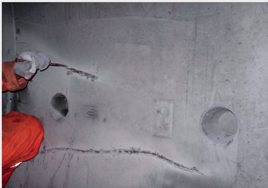
Fig. 6. Apertura della fessura
