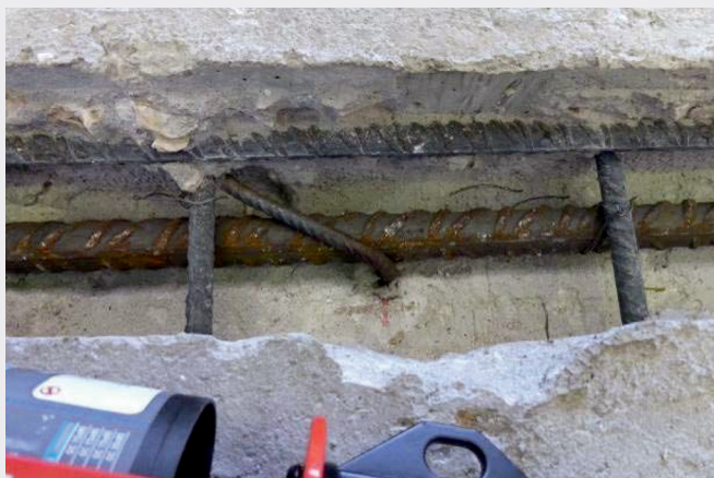
Figura 24. Dettaglio barre di rinforzo.
