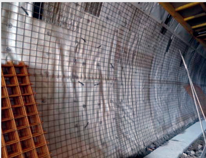
Fig. 15 Fissaggio della rete di armatura.
