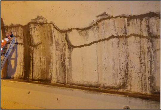
Danno B1 - Iniezione delle fessure
