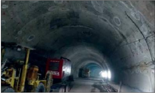
Danno A1 - Assenza di acqua, fessura di piccola entità
