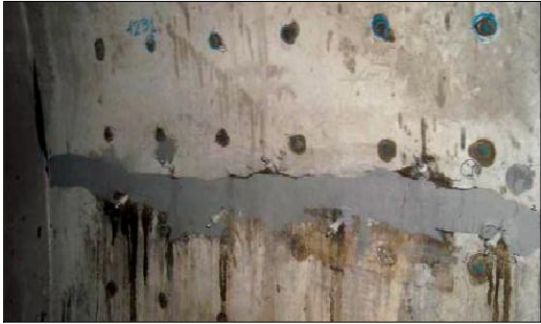
Danno A2 - Applicazione di packer meccanici ed iniezione con resina epossidica a bassa viscosità
