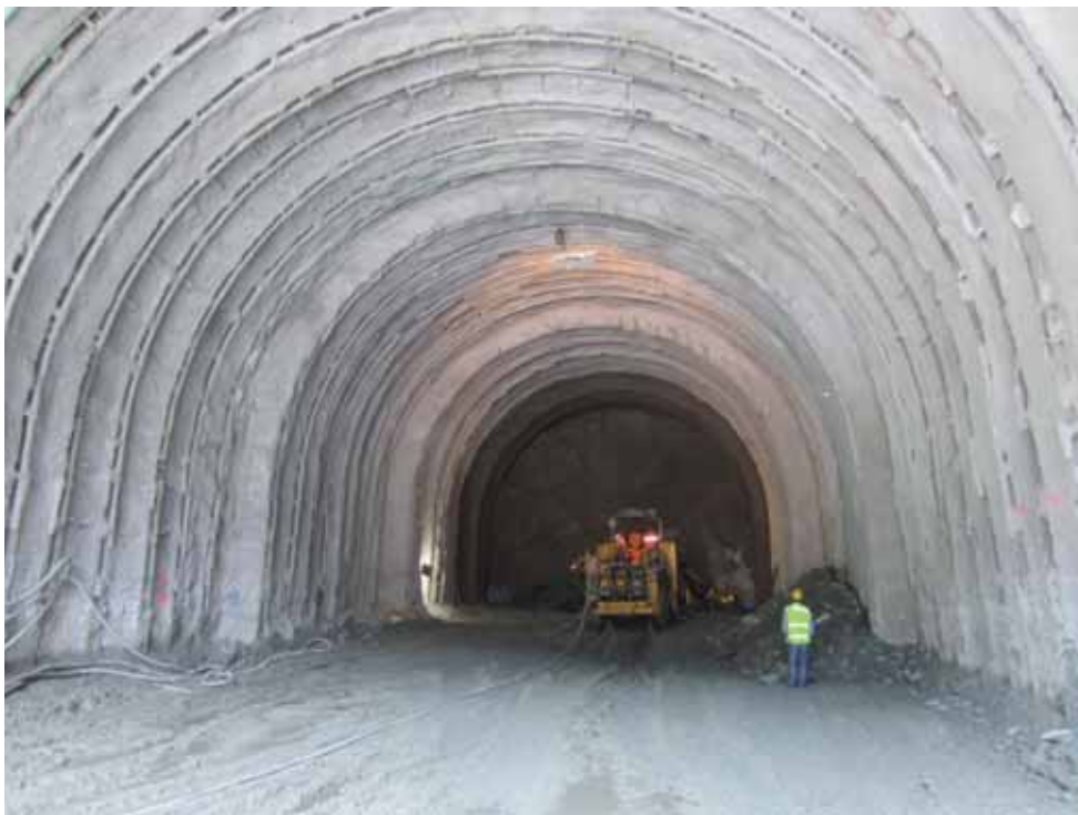
Figura 3.26 – Lo scavo della galleria principale
