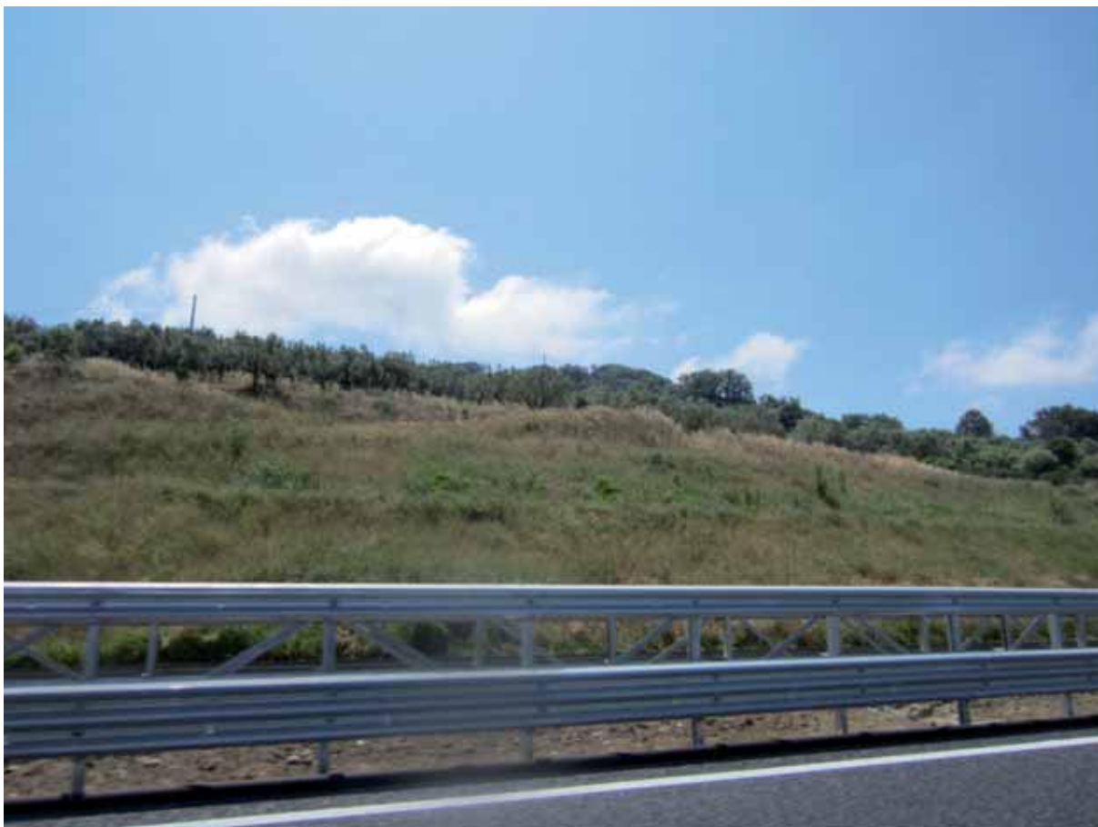
Figura 3.41 - Sistemazione del versante con la tecnica dei Prati Armati®: tavola di progetto e fotografia ad intervento ultimato
