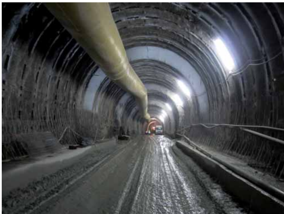
Figura 3.27 – Lo scavo della galleria di emergenza
