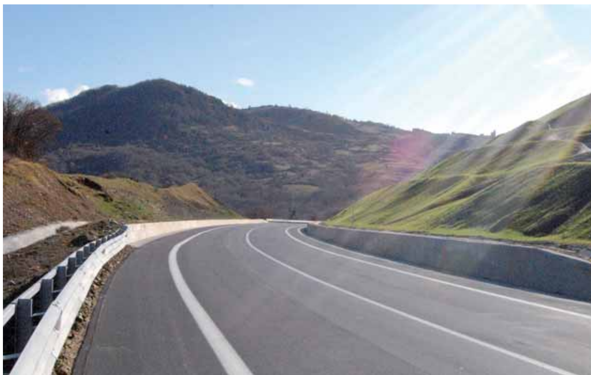
S.S. 17 - Variante A - Tratto in trincea
