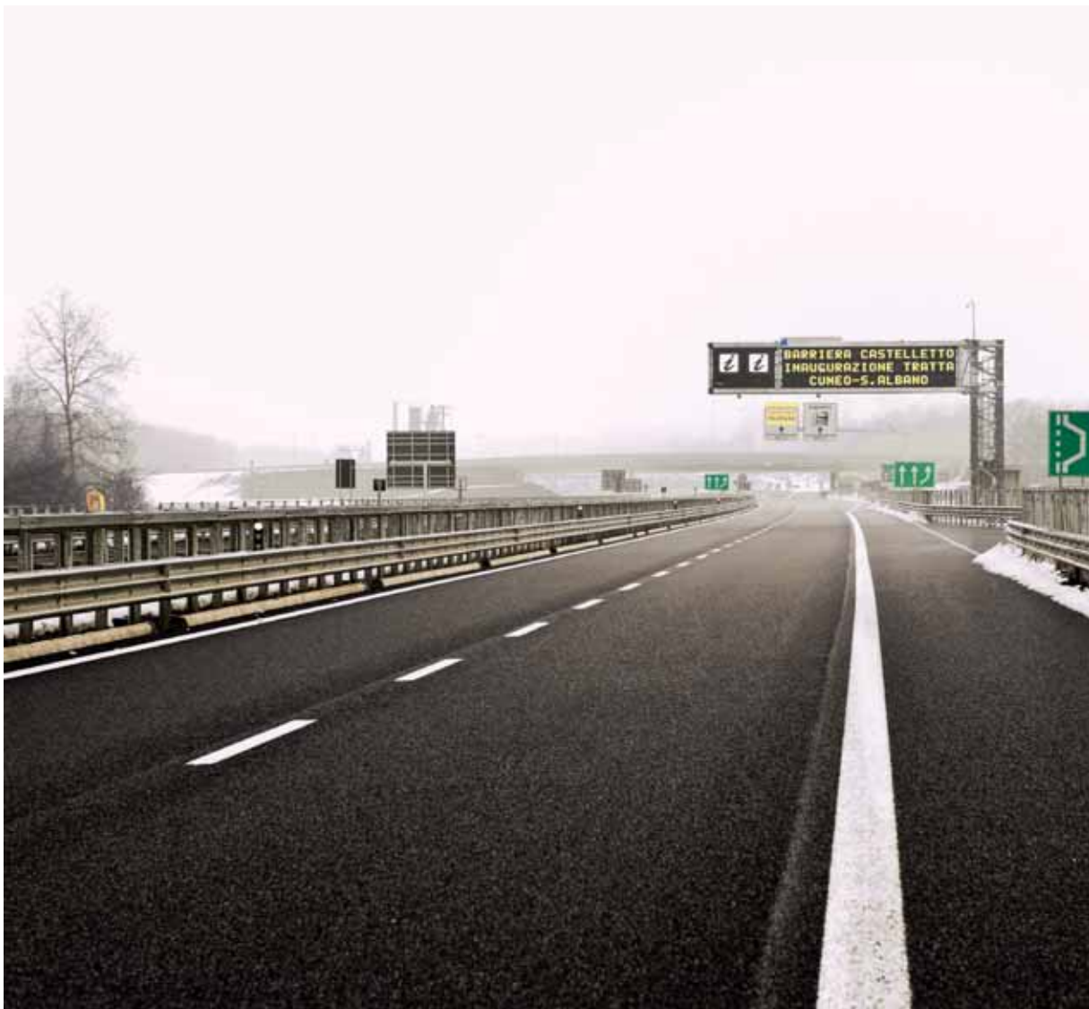
Autostrada Asti-Cuneo - Tratto Cuneo-Sant'Albano Stura
