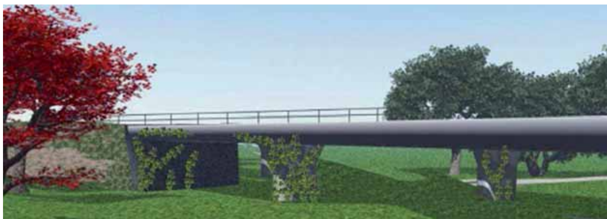
Figura 3.17 - Esempio rinverdimento pile viadotto tramite lianose
