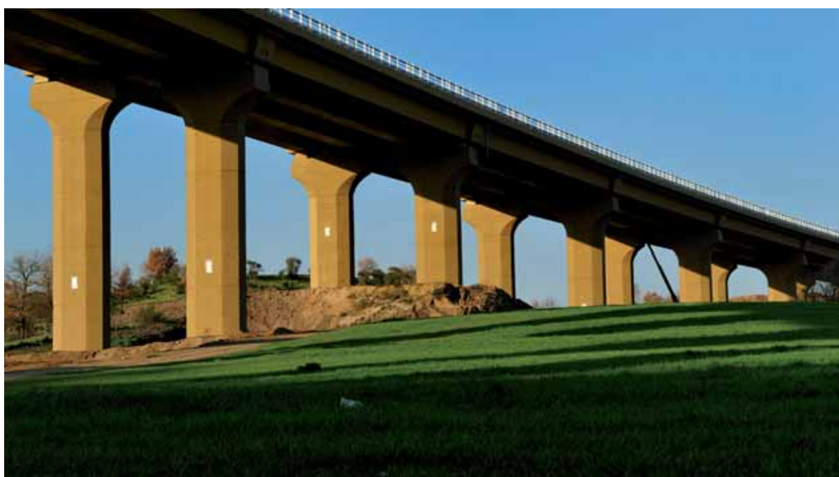
S.S. 675 "Umbro-Laziale" - Viadotto "Boia"
