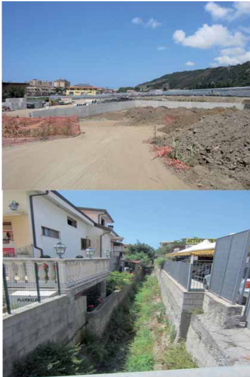
Figura 3.42 - La costruzione del sistema di vasche di laminazione presso lo svincolo di Falerna (a sinistra); la situazione attuale di uno dei corsi d'acqua (Valeo 2) che attraversano l'abitato, pericolosamente compromesso da una edificazione selvaggia (a destra)
