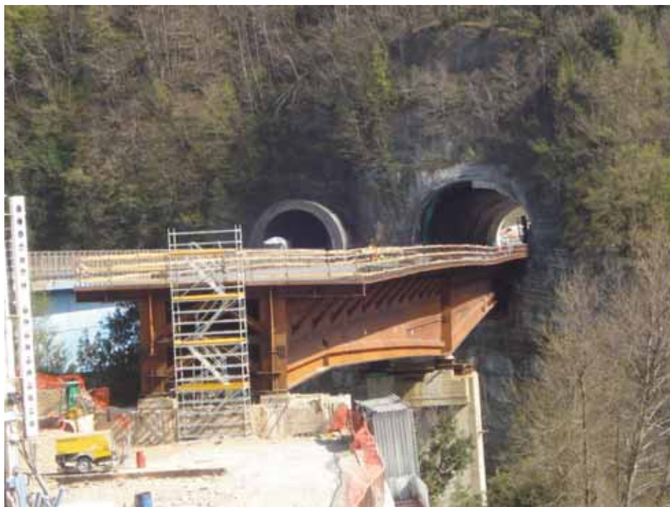
Figura 3.35 – Lavori di costruzione del viadotto Serra Sud
