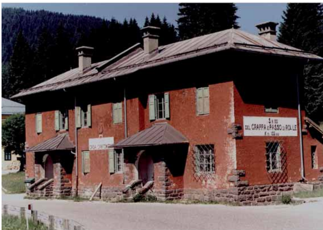
Figura 3.1 – Casa cantoniera ANAS lungo la S.S.50 del Grappa e Passo di Rolle
