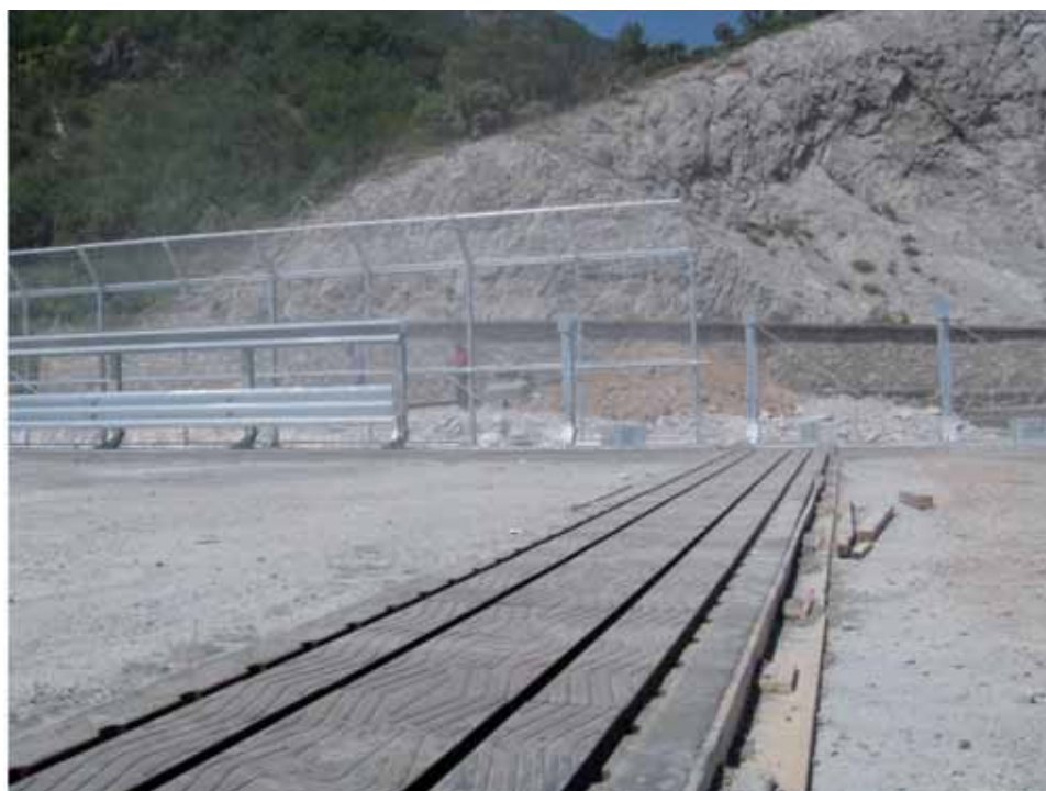
Figura 3.39 – I giunti dei viadotti sono di tipo antisismico: la gomma di cui sono composti isola la struttura del viadotto dalle sollecitazioni meccaniche, orizzontali e verticali, dovute ai movimenti dell'eventuale sisma
