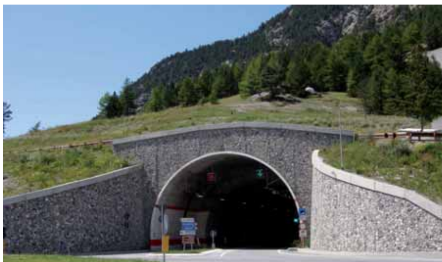
Figura 3.51 - La galleria di Clavière, parte del cantiere della S.S. 24
