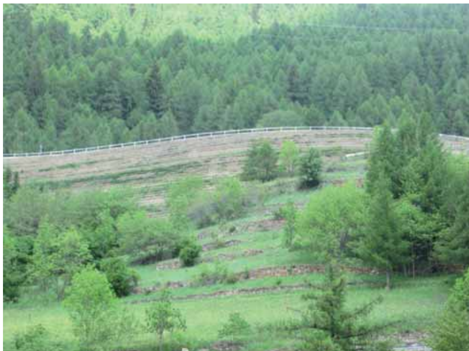
Figura 3.28 – Schema di progetto (in alto) e realizzazione (in basso) di terre rinforzate in corrispondenza dello svincolo Cret, costruite con il materiale di risulta dello scavo. La superficie esterna è stata realizzata in modo da poter essere colonizzata dalla vegetazione in modo naturale
