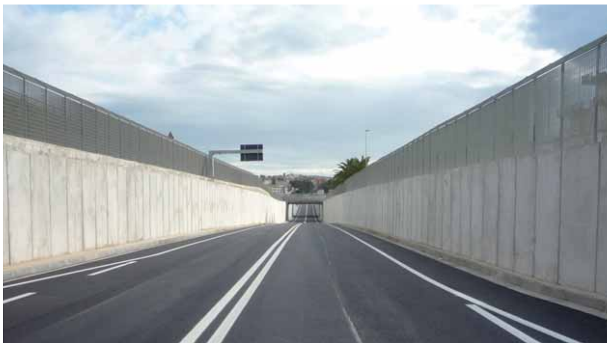
Strada Statale 115 "Sud occidentale Sicula" - Lotto Baiata-Sciacca Nord
