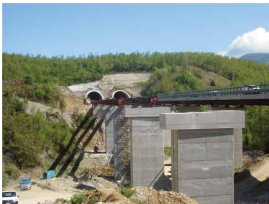
Figura 3.34 – Lavori di costruzione del viadotto Malvo Nord
