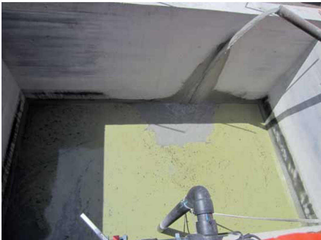
Figura 3.30 – Flusso di acqua in ingresso all'impianto di depurazione
