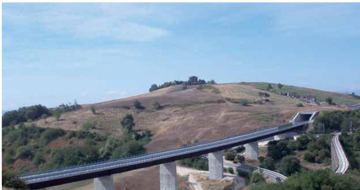
S.S. 87 Sannitica - Vista panoramica - Viadotto Macchia della Selva
