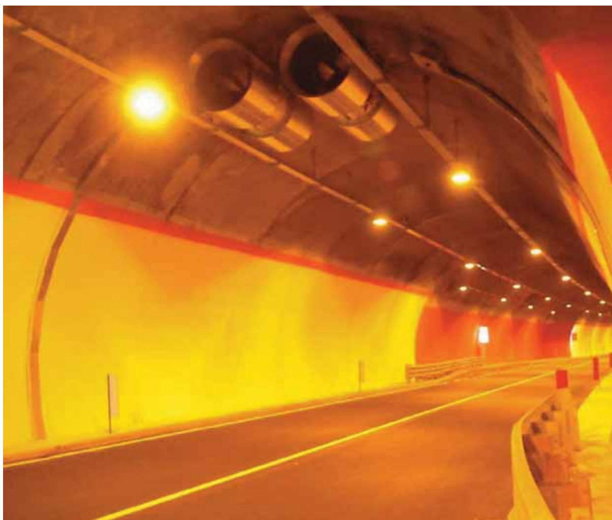
Figura 3.13 - Esempio di dotazione impiantistica in galleria
