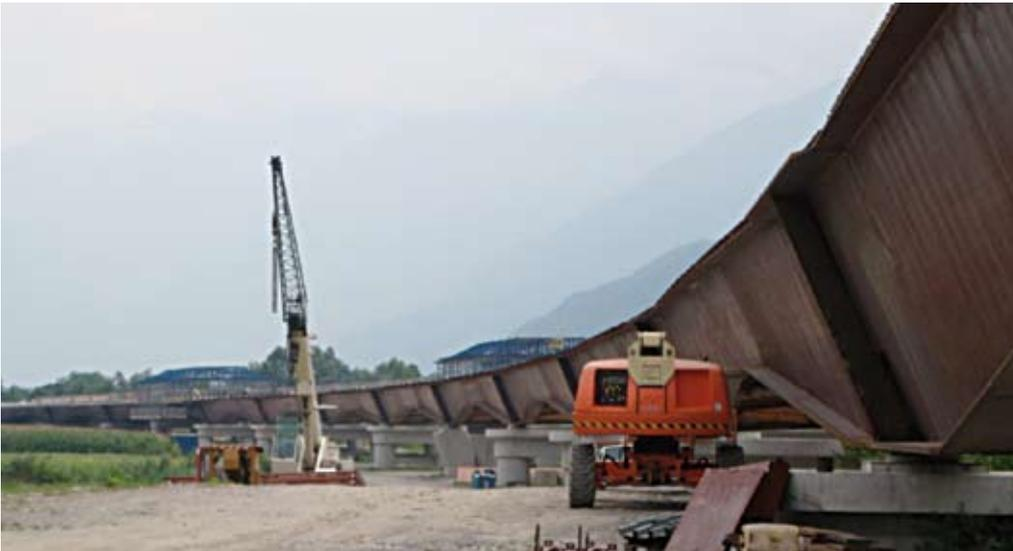
*Figura 3.20 - Realizzazione del viadotto principale in zona di esondazione; si noti lo spazio lasciato libero al di sotto delle campate per permettere il naturale deflusso delle acque straripate*
