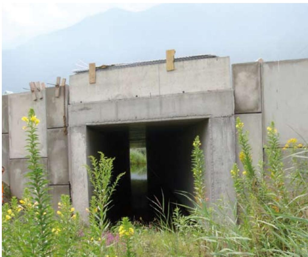
*Figura 3.21 - Sottopasso faunistico in corso di realizzazione sulla S.S.38*
