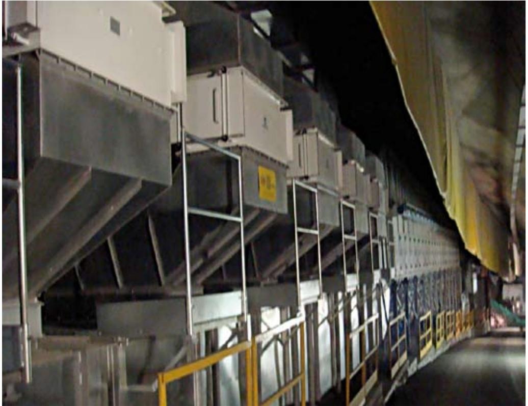
*Figura 3.16 – Particolare dell'imponente sistema di filtrazione aria, già utilizzato nel corso del 2010 durante le lavorazioni per l'esecuzione dei sondaggi e pronto per essere riavviato quando riprenderanno i lavori di scavo nell'autunno 2011*
