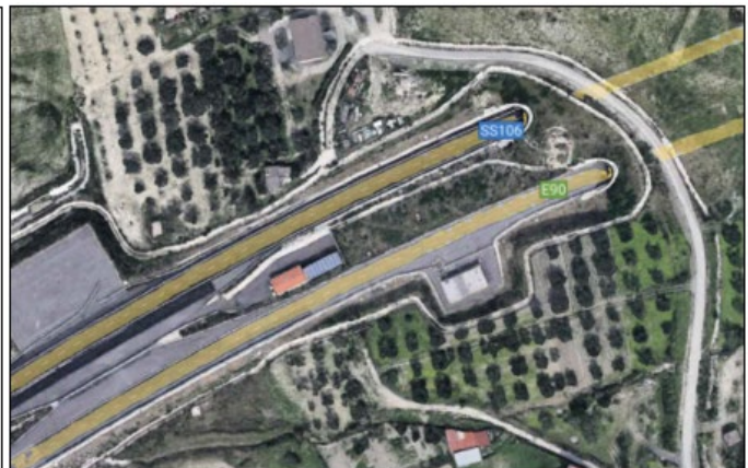
Figura 2 Ortofoto S.S. 106 Galleria Santa Maria
