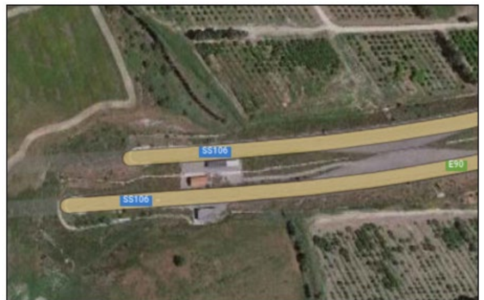
Figura 6 Ortofoto S.S. 106 Galleria Bellino Nord
