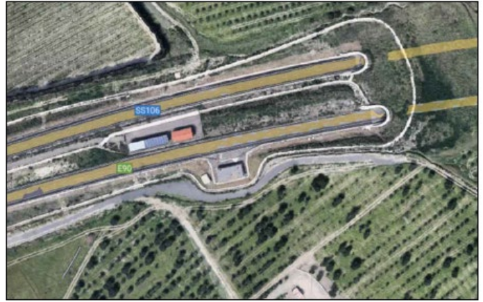
Figura 4 Ortofoto S.S. 106 Galleria Bellino Sud
