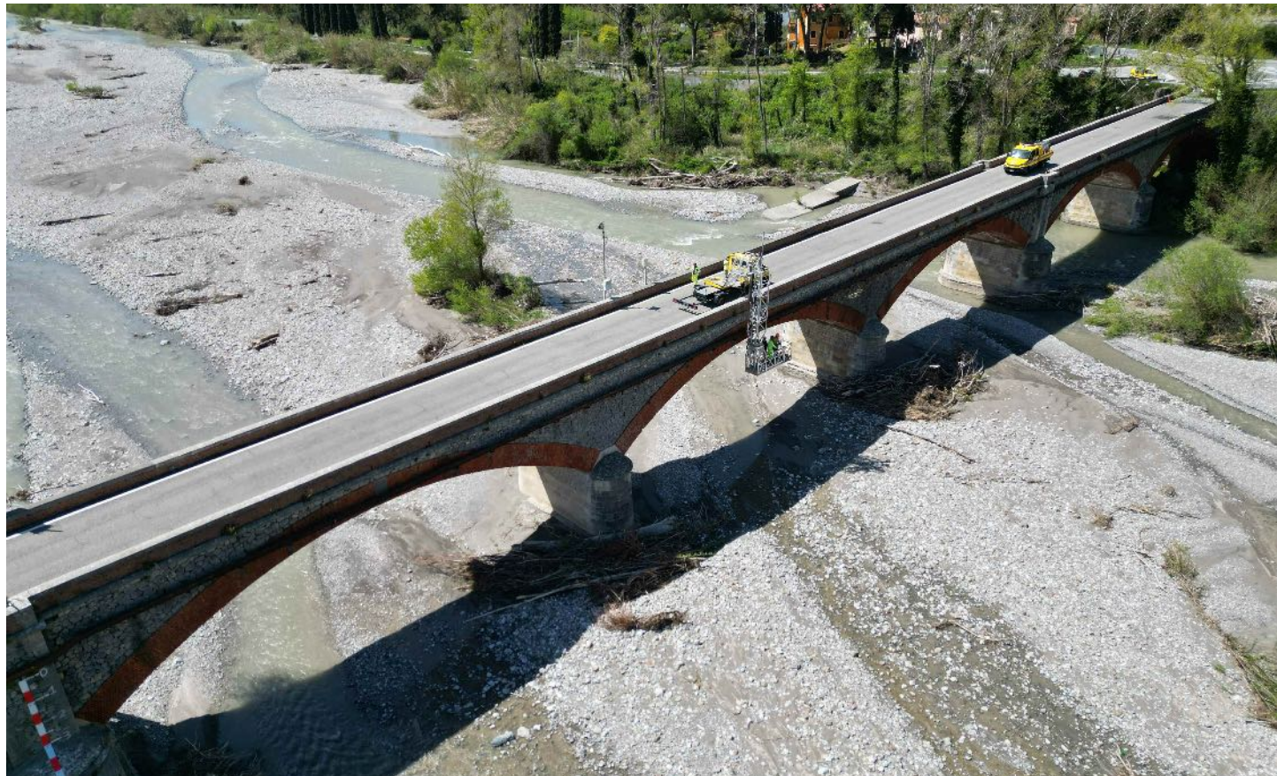
BASILICATA - STRADA STATALE 18 'TIRRENA INFERIORE', ISPEZIONI CON BY BRIDGE VIADOTTO CASTROCUCUCCO
