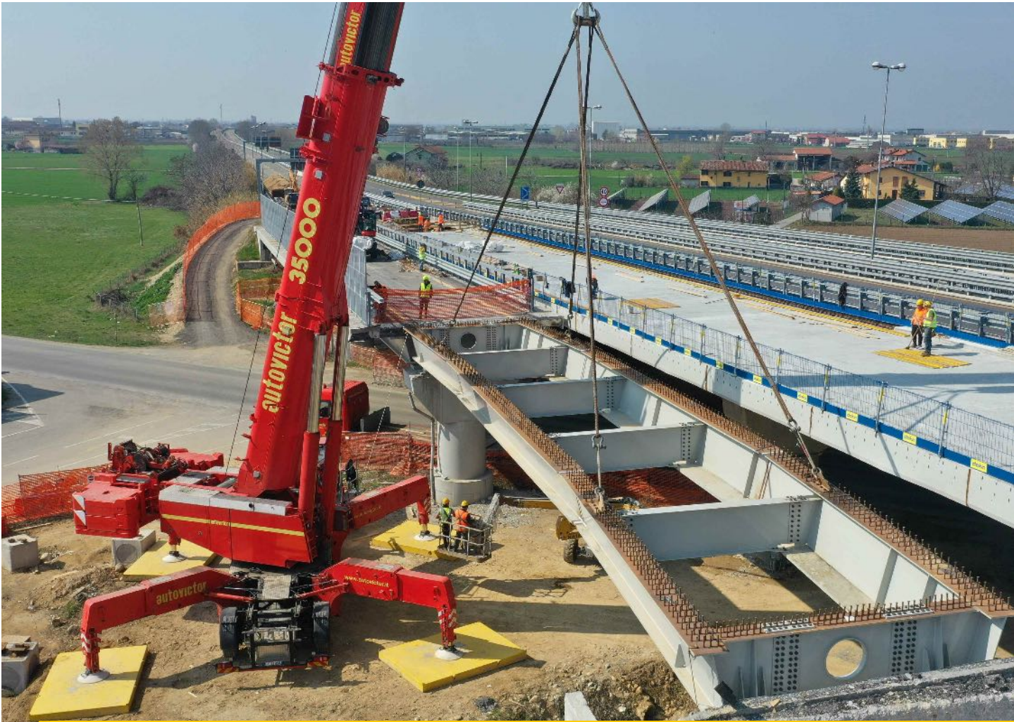
PIEMONTE - VARO VIADOTTO DI RAMPA LA REALE SULLA STRADA STATALE 231 'DI SANTA VITTORIA' - TANGENZIALE DI FOSSANO
