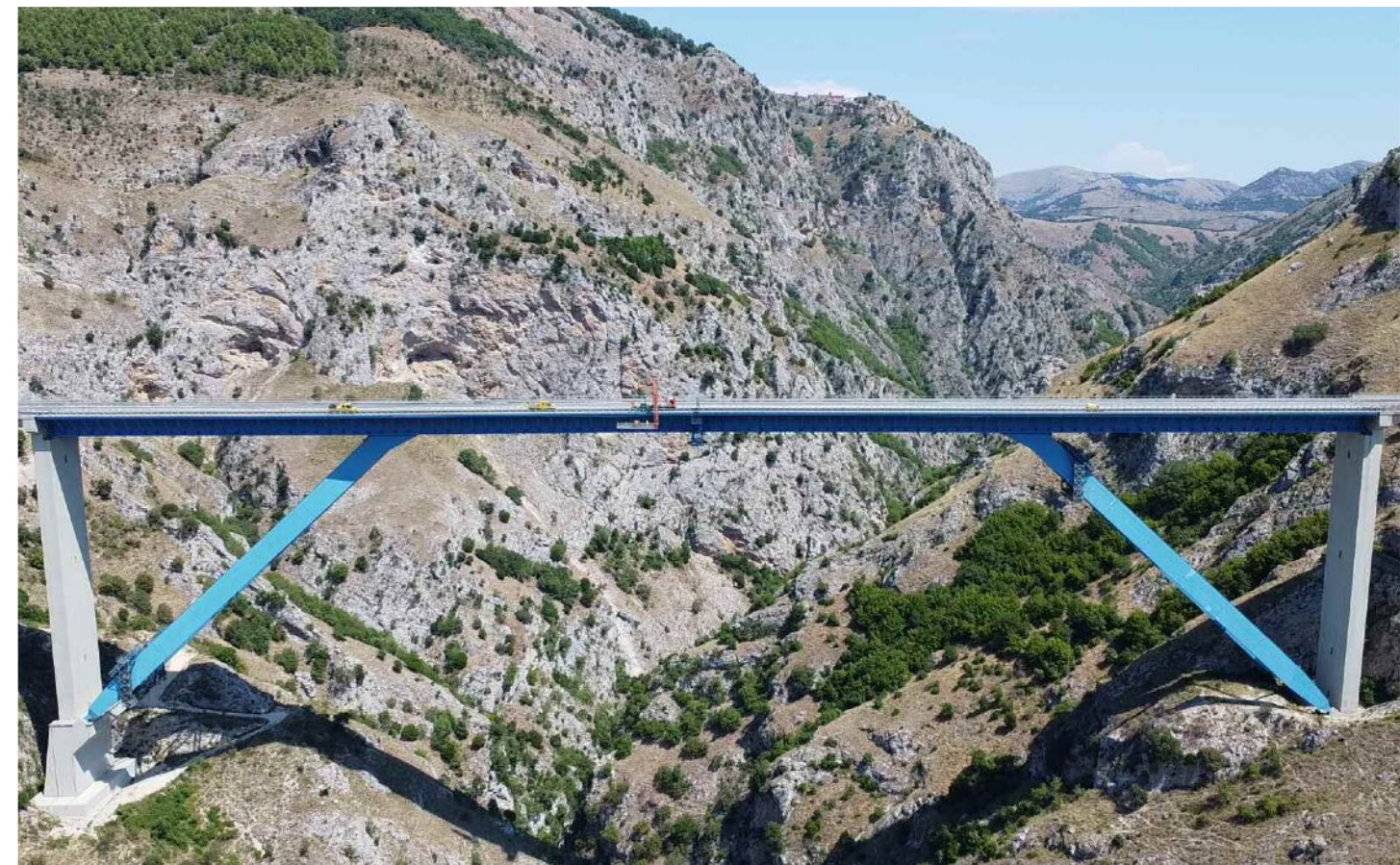
BASILICATA - RACCORDO AUTOSTRADALE 5 'SICIGNANO-POTENZA', ISPEZIONI CON BY BRIDGE VIADOTTO PLATANO
