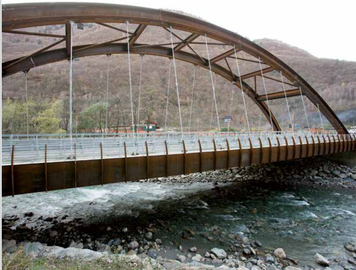
■ S.S. 42 "del Tonale e della Mendola" - Ponte Saletto
