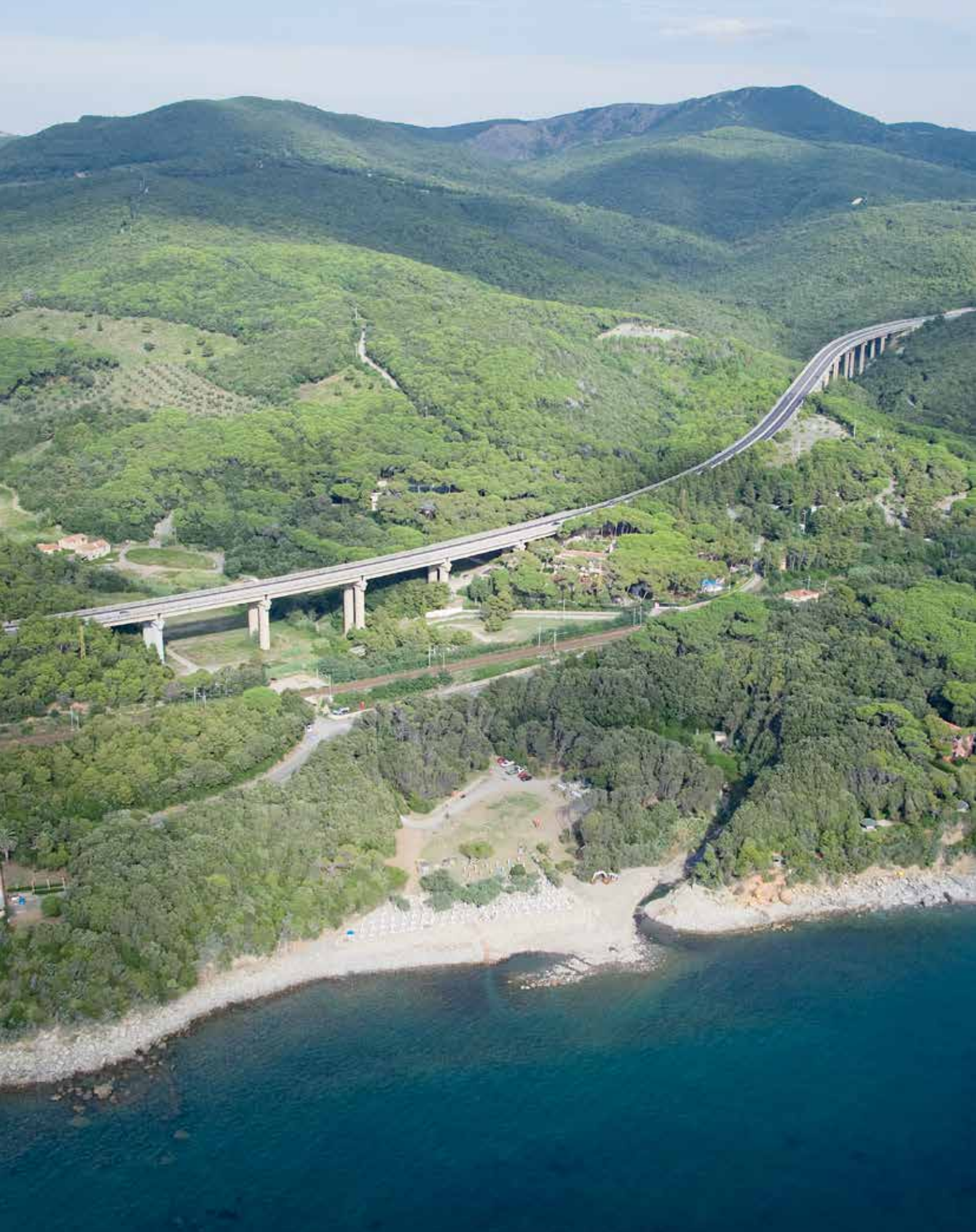
■ S.S. 1 "Aurelia" - Località Fortullino Due Viadotti
