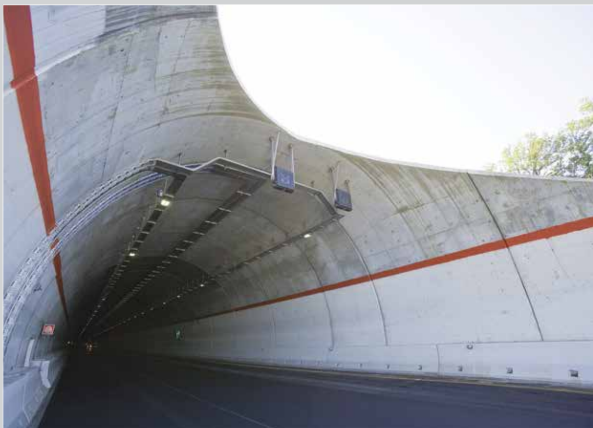
■ Autostrada A3 Salerno-Reggio Calabria - Galleria Cerreta Nord
