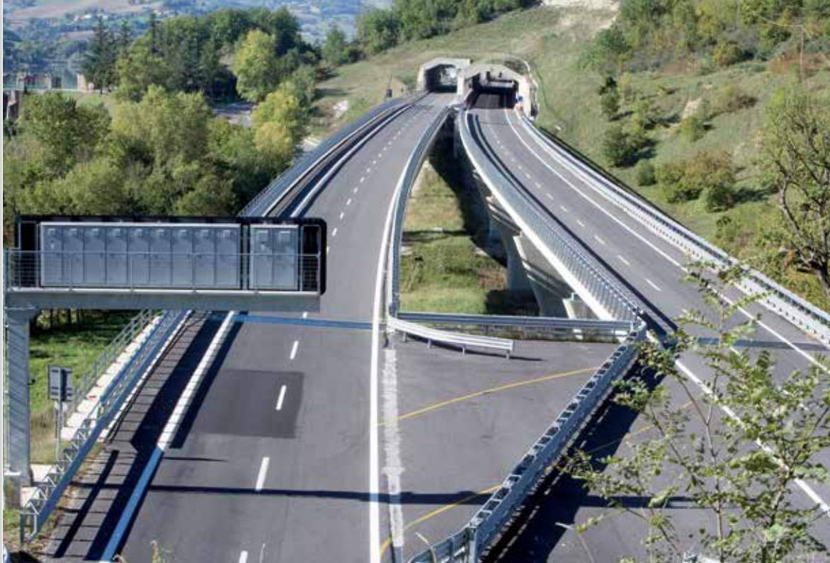
■ S.S. 77 "della Val di Chienti" - Viadotto Polverina
