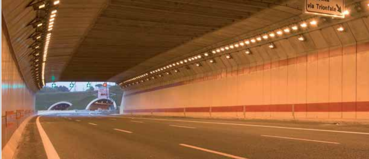
■ Autostrada del Grande Raccordo Anulare di Roma - Galleria Cassia
