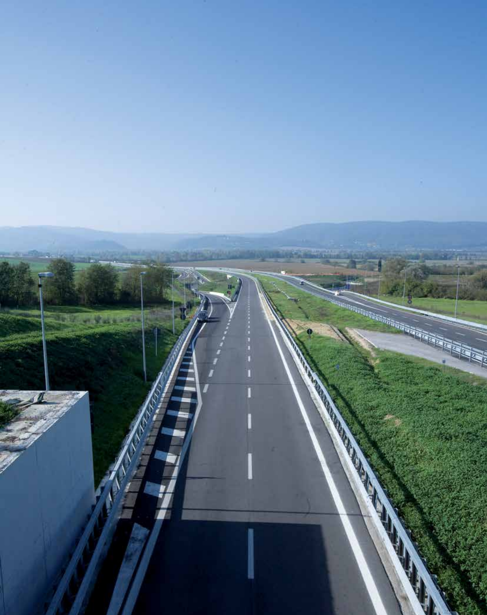
■ SGC E45 "Grosseto-Fano" - Svincolo S. Rocco a Pieve
