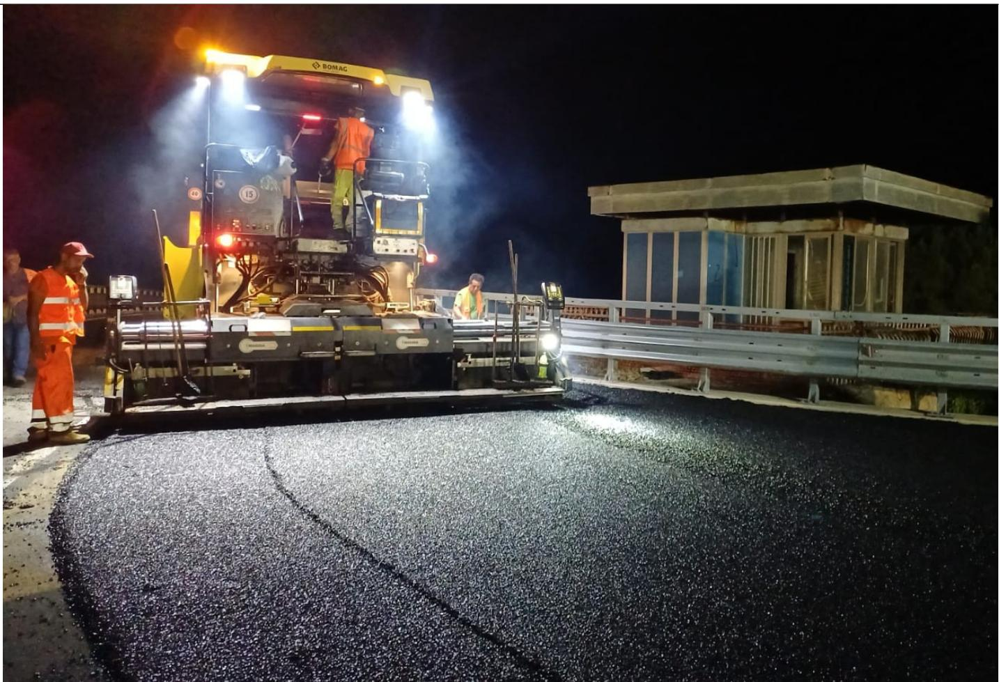
Lungo l'autostrada A19 "Palermo-Catania", nel pieno rispetto del cronoprogramma stabilito, Anas ha completato la sovrastruttura stradale delle rampe dello svincolo di Enna attraverso la posa in opera della pavimentazione drenante. Tutte e tre le fasi sono state portate a termine senza arrecare disagi all'utenza. Le lavorazioni sono state effettuate in orario notturno proprio per minimizzare l'impatto sulla circolazione stradale.
