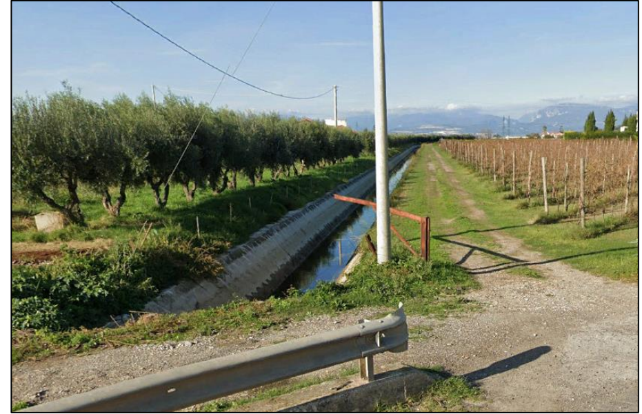
Figura 13 - Diramatore principale visto dalla SP316B.
