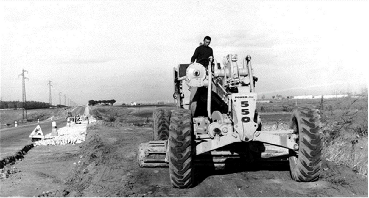
SS16 Adriatica allargamento sede stradale (1962)
