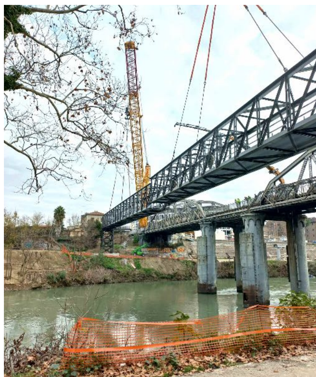
“Cantiere a Ponte dell'Industria”
