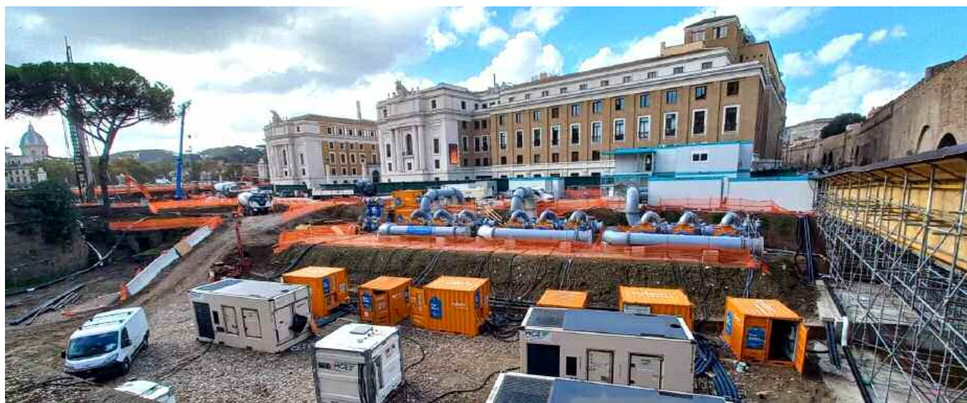
"Cantiere a Piazza Pia"
