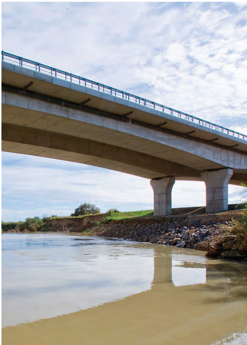
Autostrada Catania-Siracusa - Viadotto Simeto
