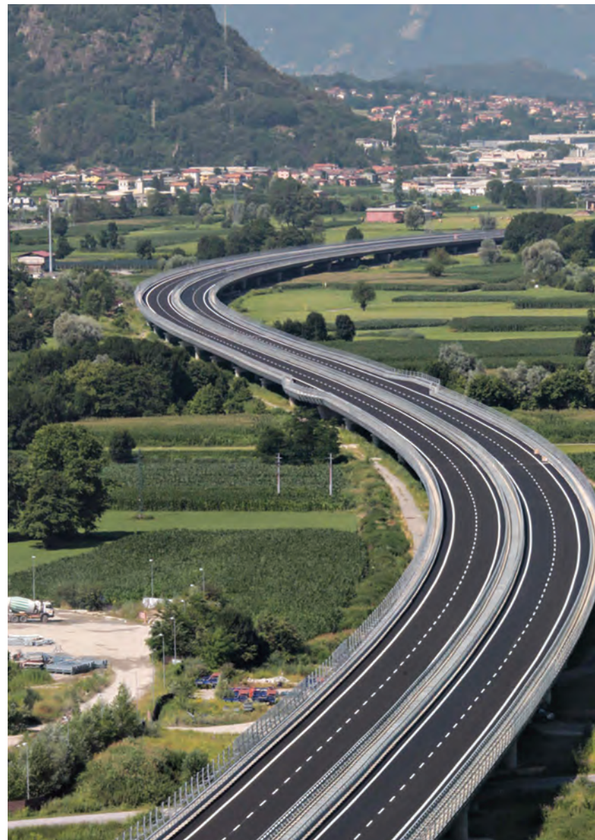
S.S. 38 "dello Stelvio" - Viadotto Valtellina
