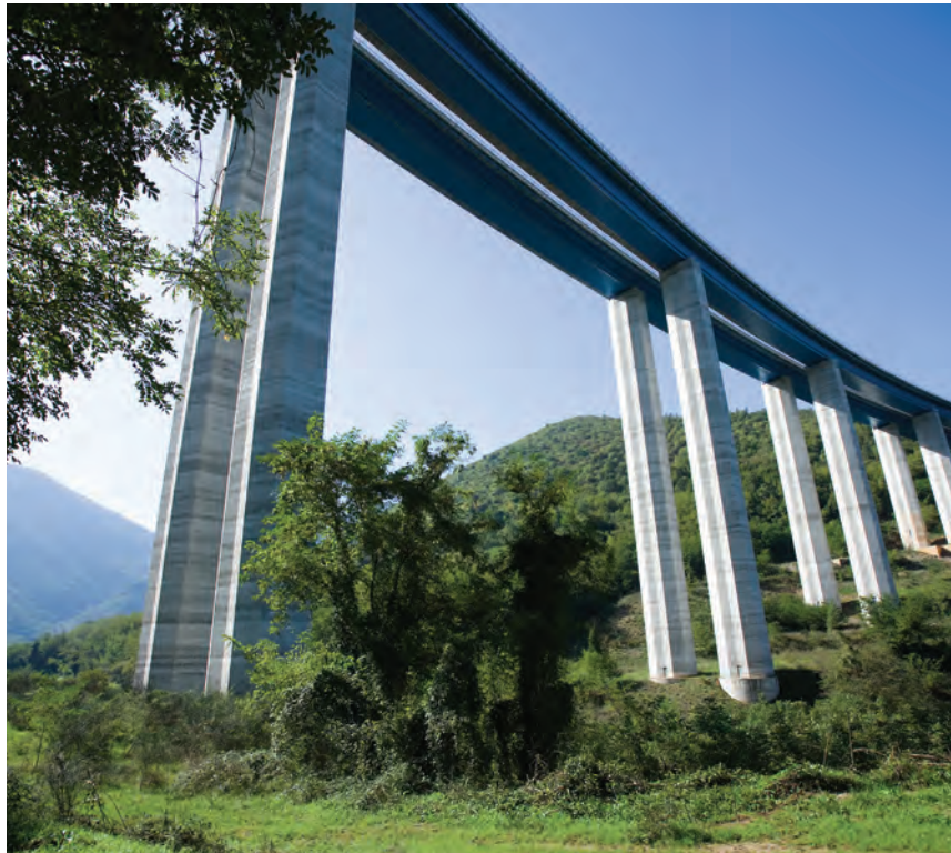
Autostrada A3 Salerno-Reggio Calabria - Viadotto Lontrano
