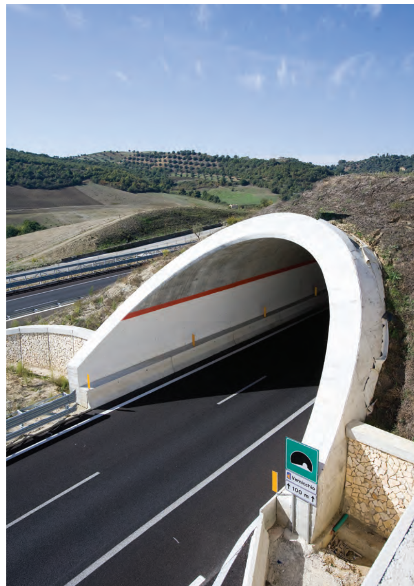
Autostrada A3 Salerno-Reggio Calabria - Galleria Serra dell'Ospedale Nord
