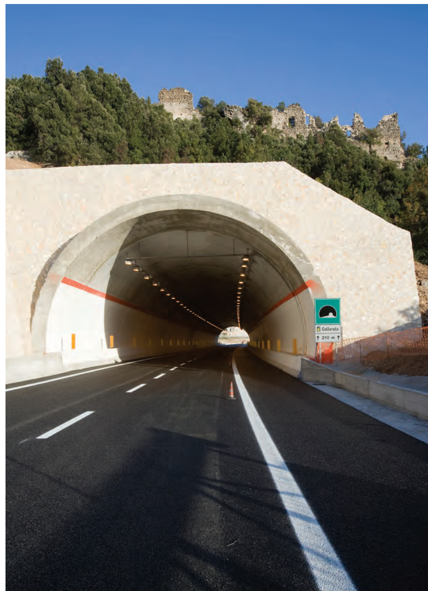
Autostrada A3 Salerno-Reggio Calabria - Galleria Collereto Sud
