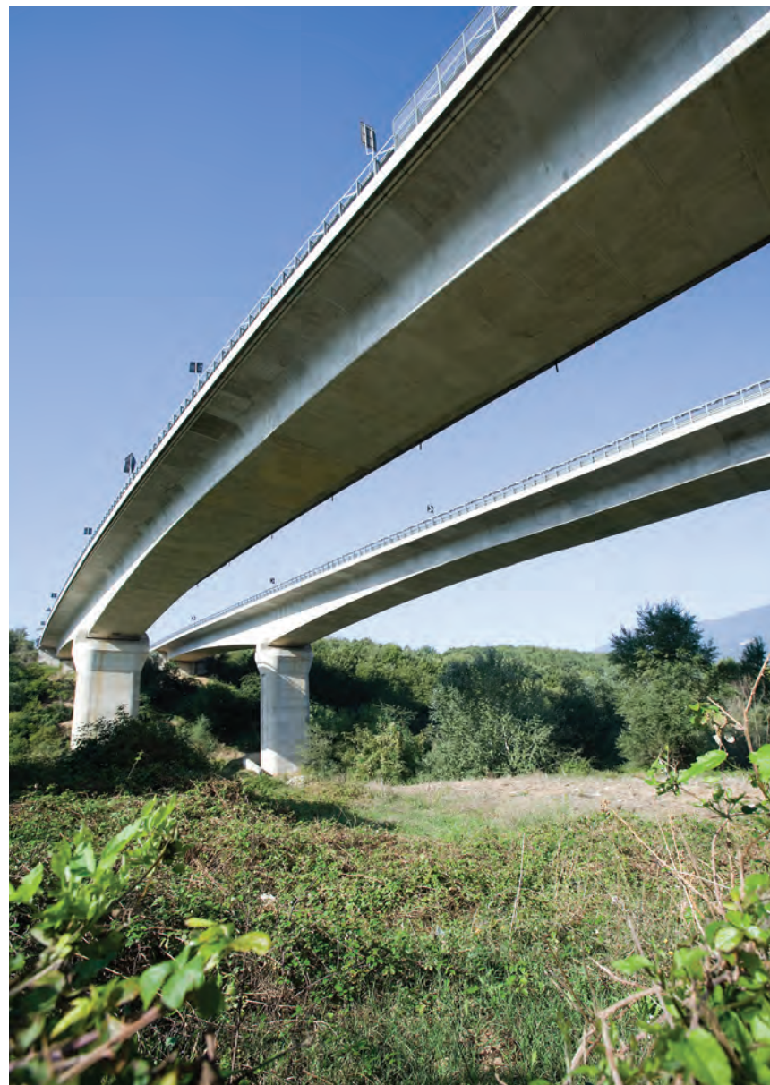
Autostrada A3 Salerno-Reggio Calabria - Ponte Tensa
