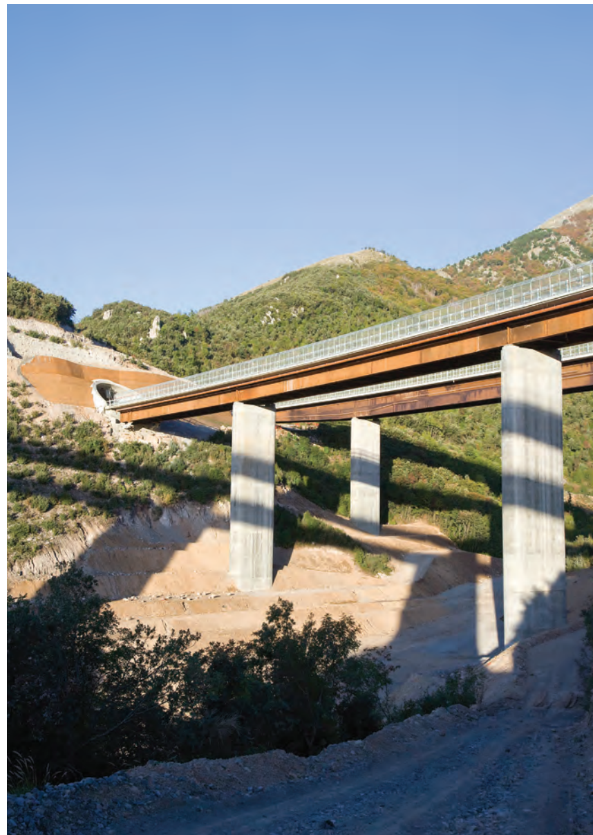
S.S. 125 "Orientale Sarda" - Viadotto Baccu Mandara
