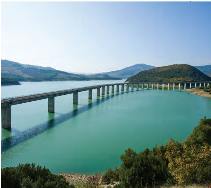
S.S. 647 "Fondo Valle del Biferno" - Viadotto Molise 1
