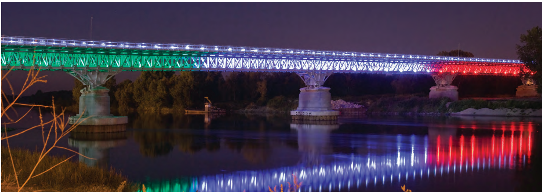
S.S. 9 "via Emilia" - Ponte sul Fiume Po
