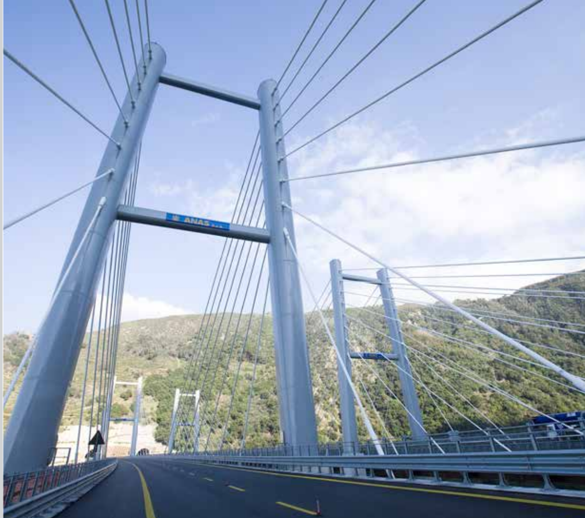
■ Highway A3 Salerno-Reggio Calabria - Viaduct Favazzina
