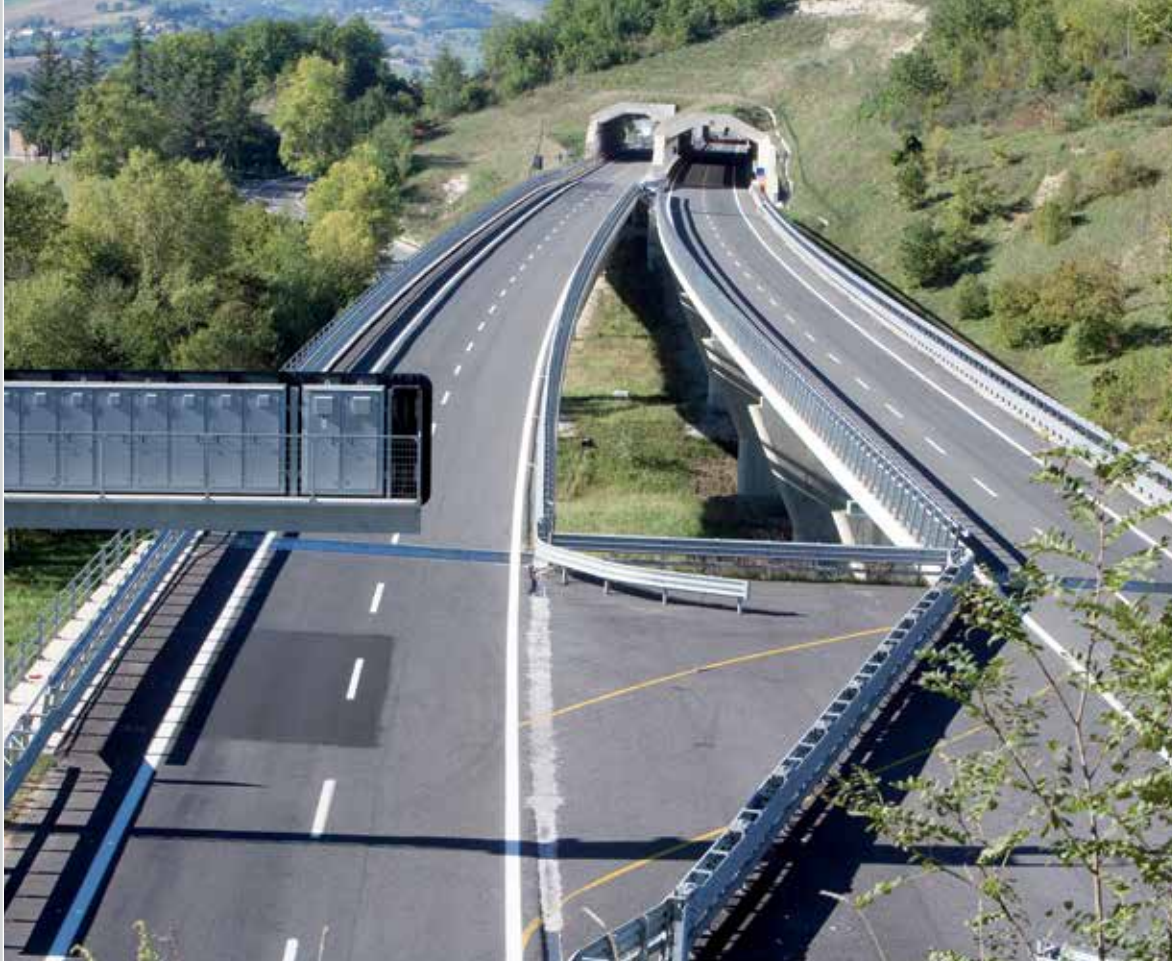
■ S.S. 77 "della Val di Chienti"- Polverina viaduct
