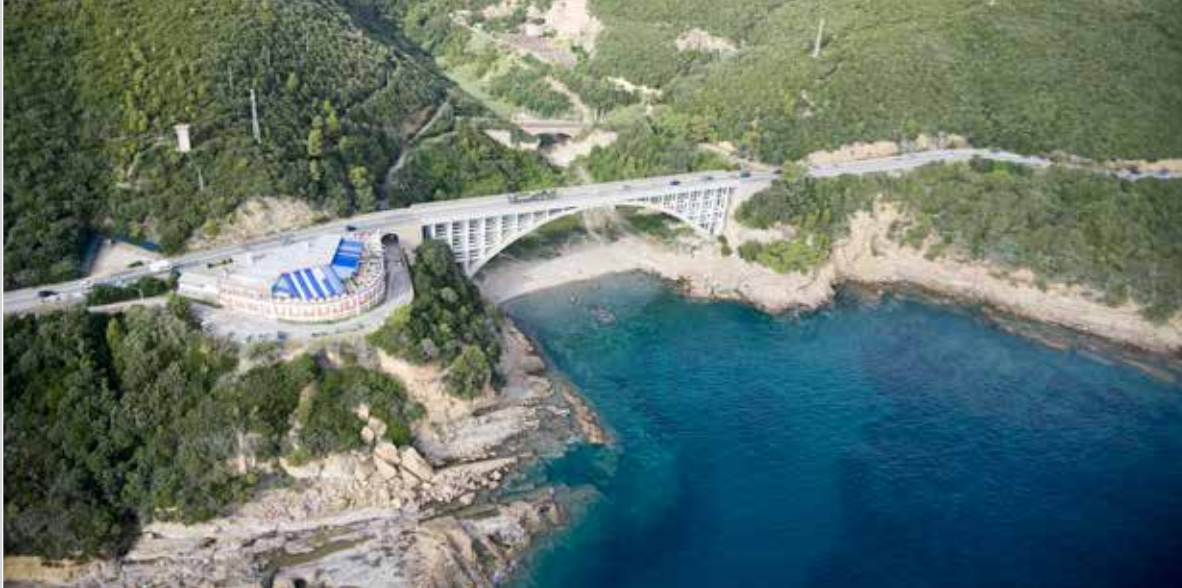
■ S.S. 1 "Aurelia" - Calignia Bridge
