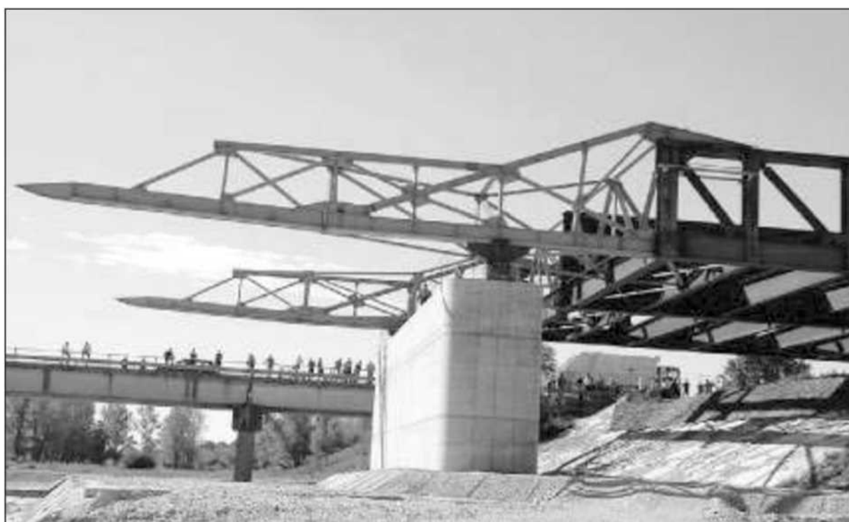
LAVORI Uno dei cantieri della Pedemontana Veneta. L'autostrada dovrebbe collegare le province di Treviso e Vicenza
