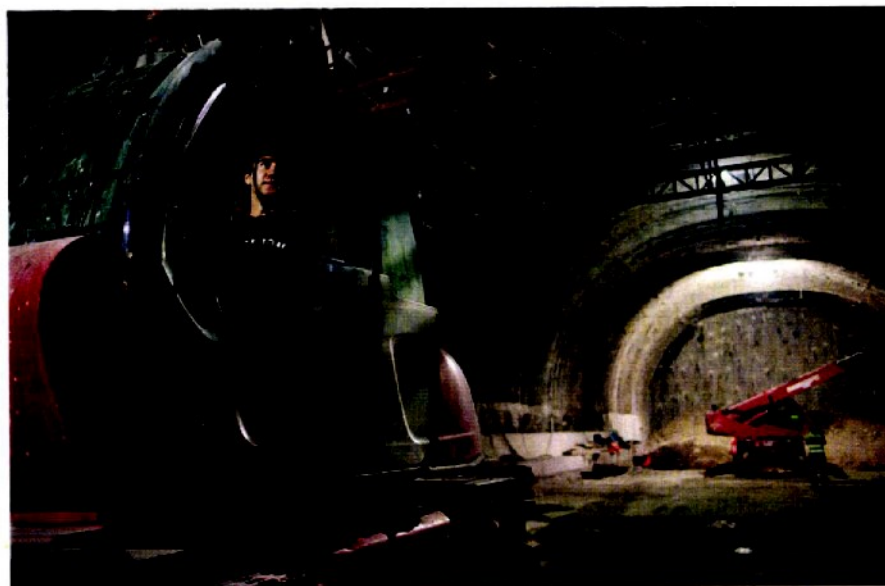
Cantiere sulla Salerno-Reggio Calabria. Sopra: Gianni Vittorio Armani
